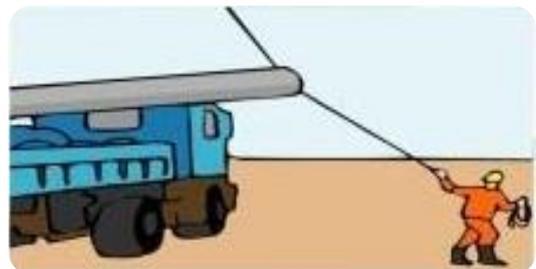
**Atenção:** É proibido colocar a mão em carga suspensa, a mesma deverá ser manuseada por cabo guia ou bastão com comprimento que garanta uma distância segura do colaborador com a carga erguida.
