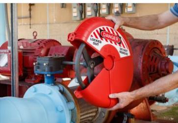
Após realizado o bloqueio, será inserido na caixa de bloqueio todas as chaves de todos os dispositivos que bloquearam as válvulas, onde todos os envolvidos na atividade irão inserir seus cadeados juntamente com a etiqueta de identificação na caixa de bloqueio.
