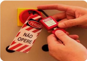
Após o teste a chave que bloqueia o dispositivo no painel elétrico, será inserido na caixa de bloqueio, onde todos os envolvidos na atividade irão inserir seus cadeados juntamente com a etiqueta de identificação na caixa de bloqueio.
